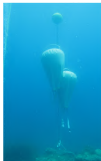
Figure 10 : Remontée des déchets par parachute
