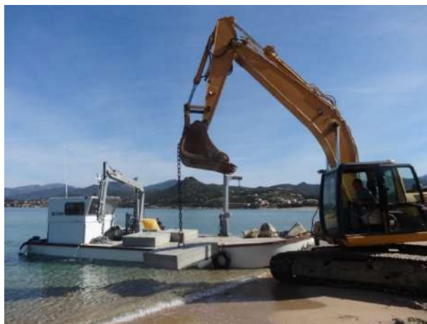
Figure 12 : Chargement des corps-morts sur la barge
